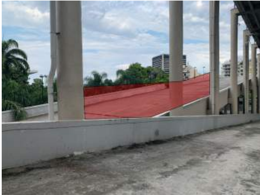
Figura 21: Detalhe da Barreira fixa (em vermelho) que impede o acesso indevido de espectadores de um setor ao outro
