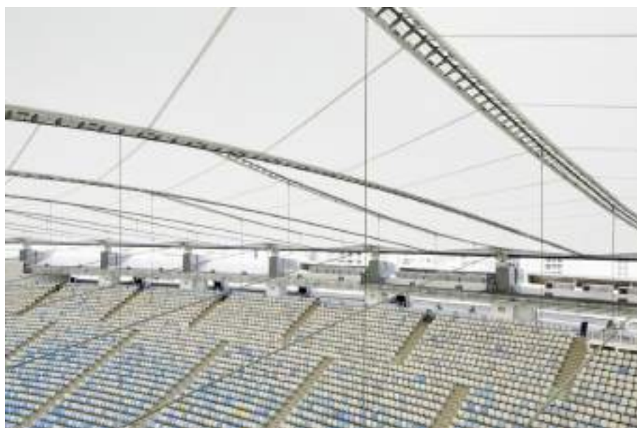
Figura 19: Mais detalhes do toldo que forma a cobertura do Estádio
