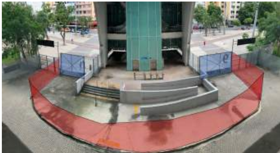
Figura 13: Criação de isolamento e cercamento do espaço para permitir a operacionalização do espaço de forma independente do Estádio nos mesmos padrões do Estádio (Belgo Nylonfor® ou equivalente)
