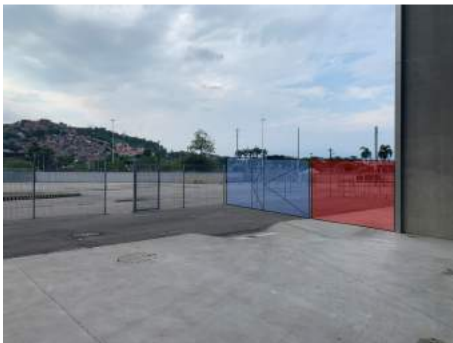
Figura 15: Portão (em azul) e barreira fixa (em vermelho) permitem o isolamento e restrição de acesso à área de embarque e desembarque das delegações e artistas
