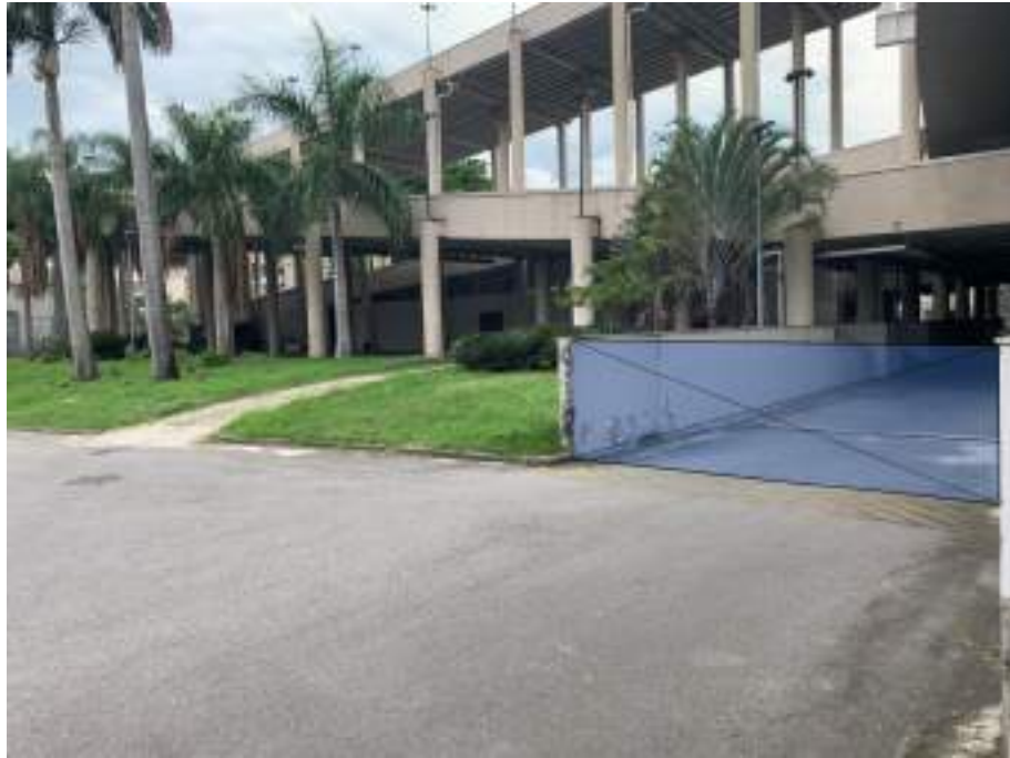
Figura 8: Portão de Acesso da embaixo da rampa do Lado Leste
