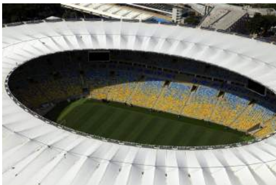
Figura 18: Detalhe da Cobertura do Estádio Maracanã
