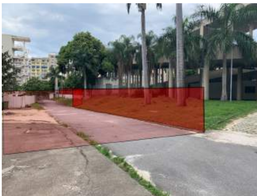
Figura 1: Criação de cercamento da nova rua e espaço do Parque Aquático Júlio Delamare, possibilitando isolamento total da instalação esportiva.
