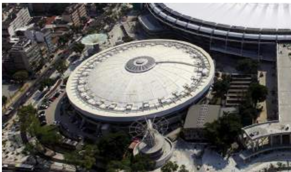
Figura 34: Imagem aérea da cobertura do Ginásio Maracanãzinho
